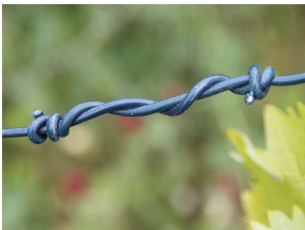
Wickelverbindungen müssen sehr eng gewickelt sein, sonst lösen sie sich bei starkem Zug. Fotos: Gerd Götz
